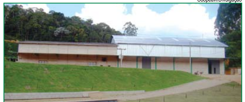
Com estrutura ampla e com capacidade de estocagem maior, o Armazém de Café da Coopeavi, será inaugurado no dia 06 de março, às 14h.
